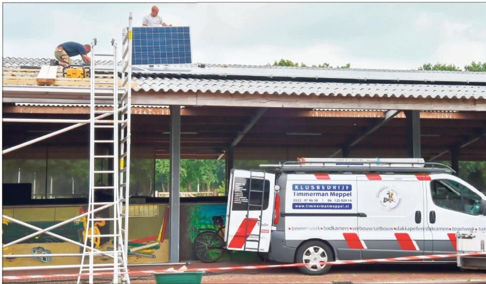
Deze week werd de laatste van 66 zonnepanelen geplaatst op het manegedak.
